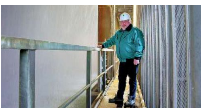
Christian Schulz-Giesdorf von der Infra Zeitz gewährt einen Blick in einen der vier bestehenden Kühltürme.
