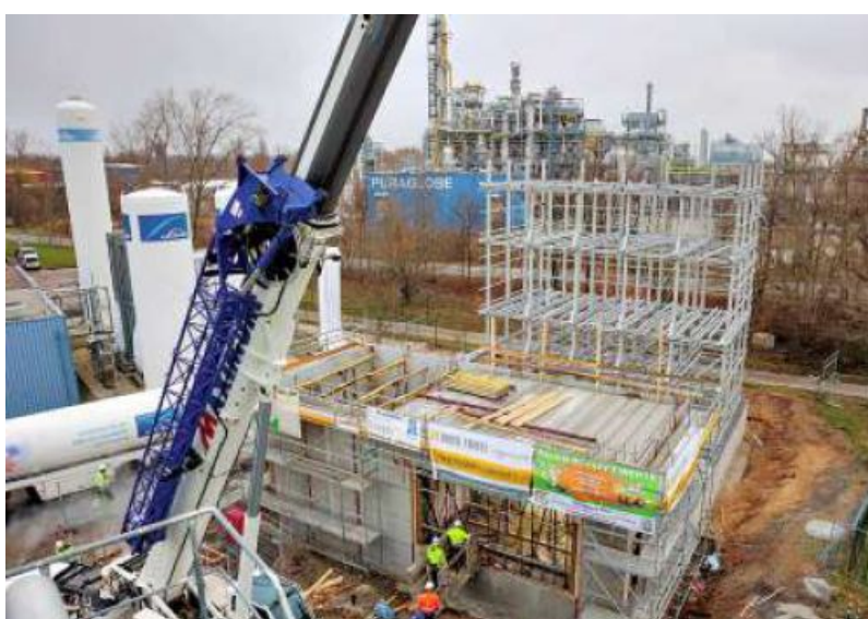
16 Meter hoch ist der neue Kühlturm im Chemiepark Zeitz.
