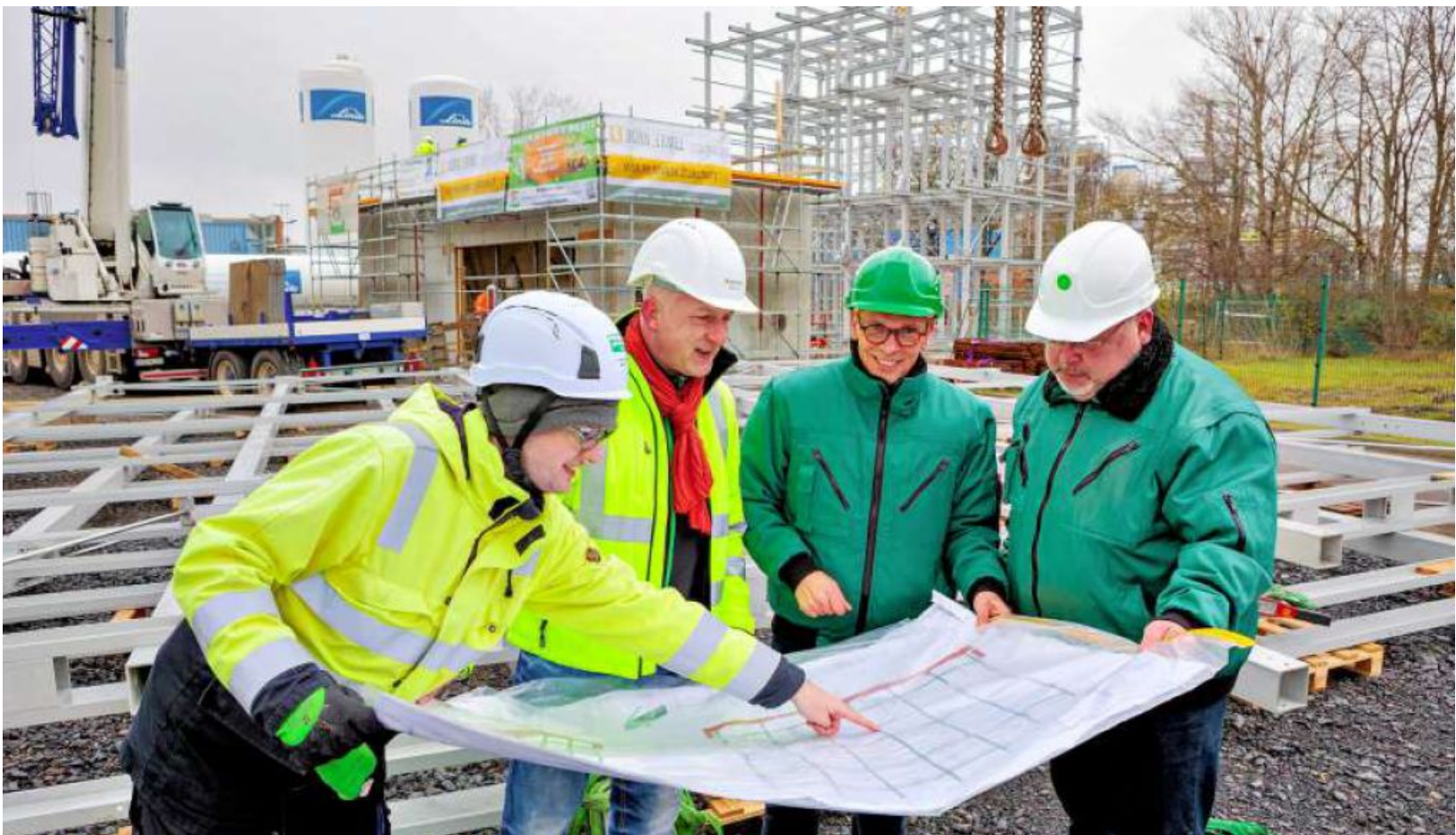
Ein neuer Kühlturm entsteht in diesen Tagen im Chemie- und Industriepark Zeitz. Stefan Wilhelm und Danny Wenzel von der sächsischen Baufirma, Infra-Geschäftsführer Christoph Hansel und Christian Schulz-Giesdorf (von links) besprechen den weiteren Plan.
